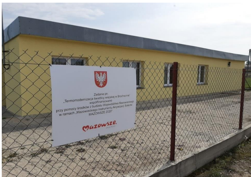
Świetlica wiejska w Brochocinie po termomodernizacji.
