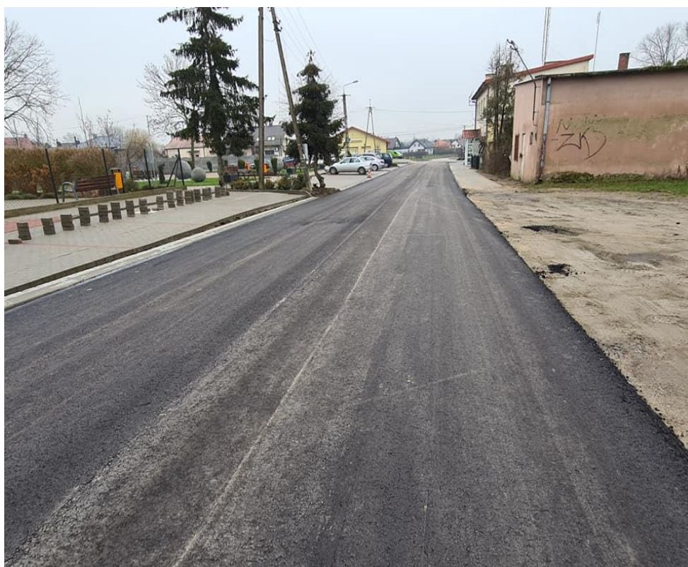
Rogozino ulica Strażacka w trakcie modernizacji
