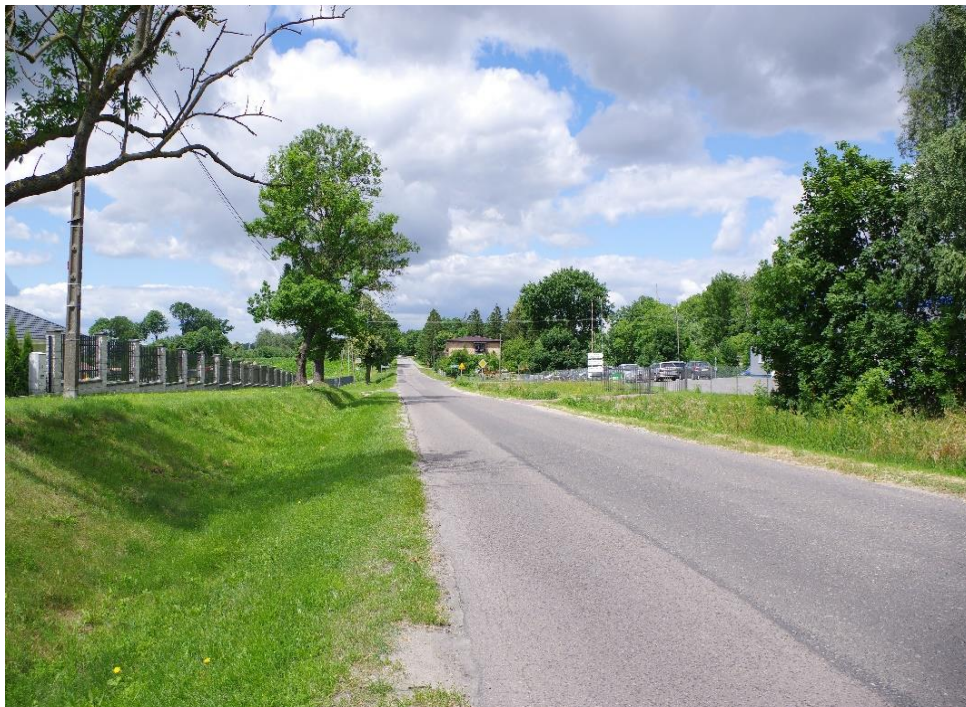
Chodnik wzdłuż drogi powiatowej przy ulicy Płockiej w Radzanowie ( przed wykonaniem prac).
