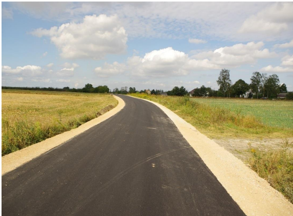
Droga w Brochocinku po przebudowie.
