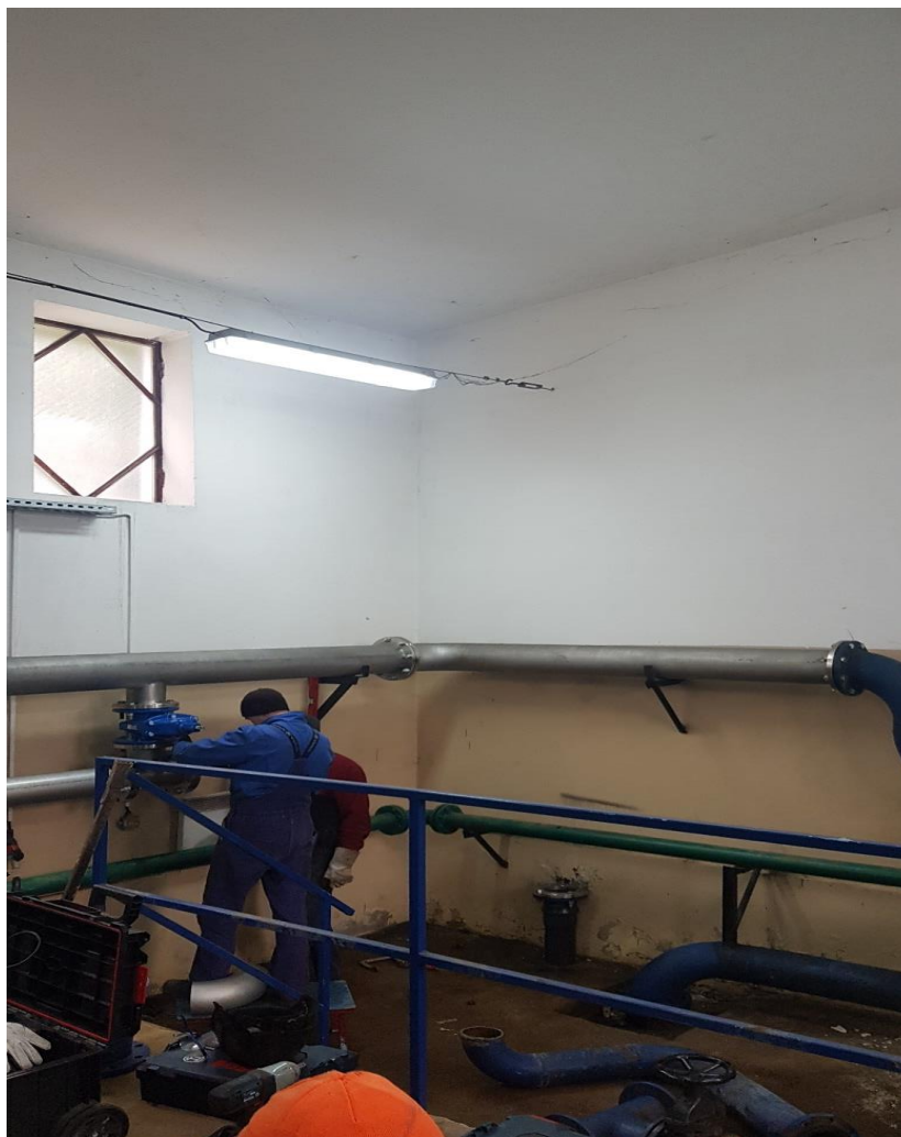
Hala produkcyjna w trakcie prowadzenia prac technologicznych
