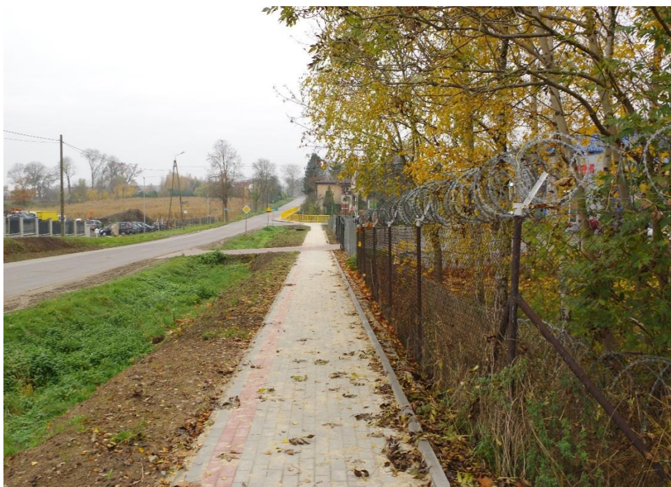
Chodnik wzdłuż ulicy Płockiej (po wykonaniu prac).
