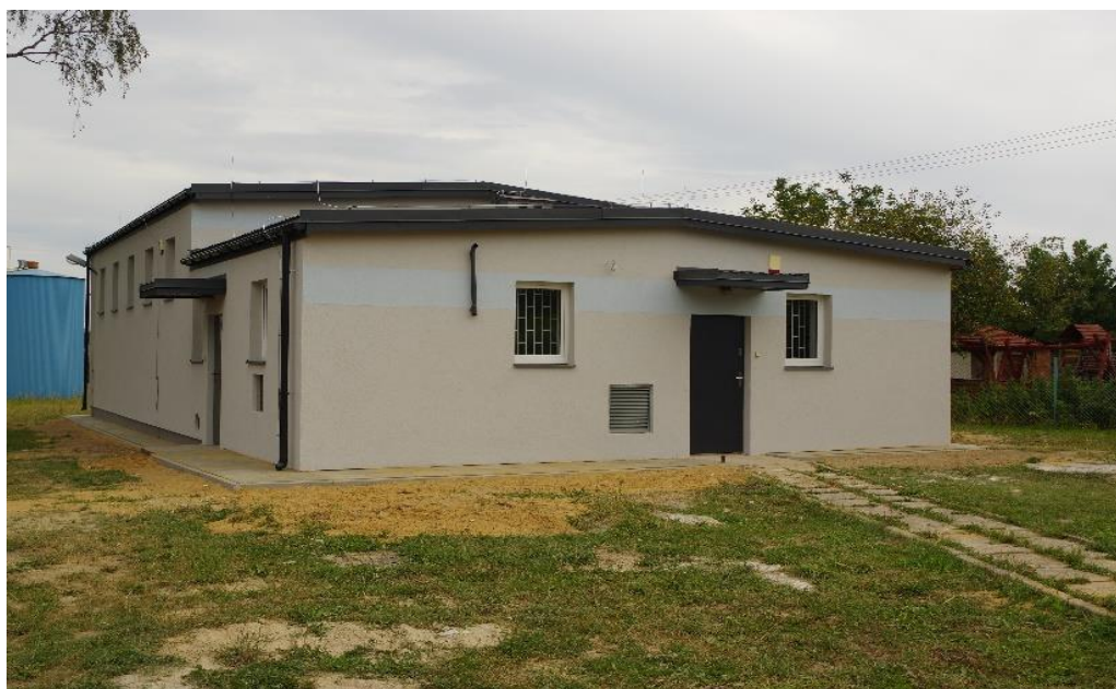
Budynek SUW Ciólkówko po modernizacji
