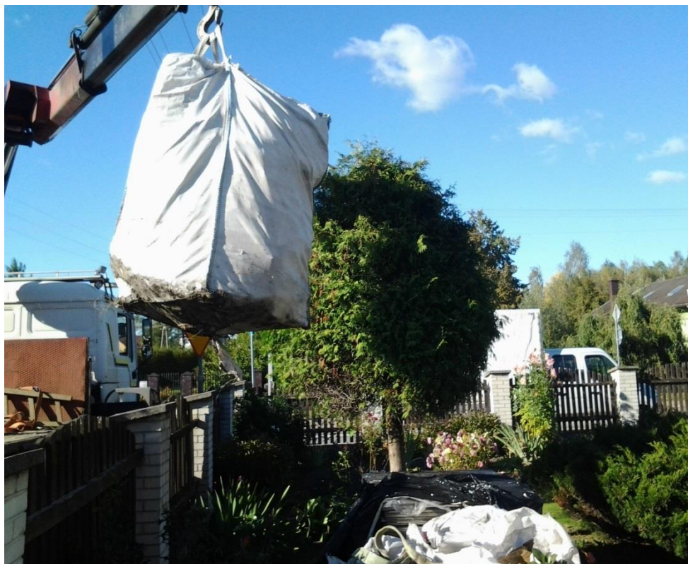
Zadanie w trakcie realizacji – odbiór azbestu
