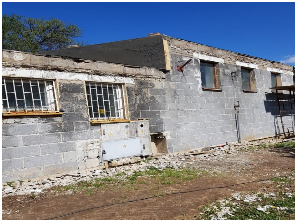
Budynek SUW Ciólkówko w trakcie prac remontowych
