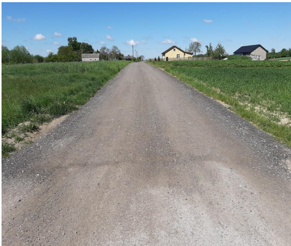
Przykładowa droga z destruktu w miejscowości Chomętowo
