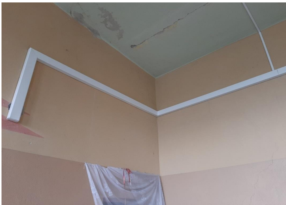
Nowa instalacja elektryczna w budynku OSP Juryszewo
