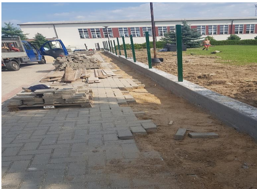
Realizacja budowy ogrodzenia w trakcie prac
