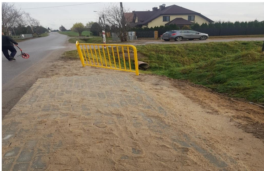
Chodnik po wybudowaniu-odcinek końcowy
