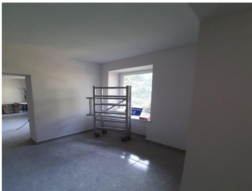
Pomalowane ściany w budynku świetlicy w Ciółkowie
