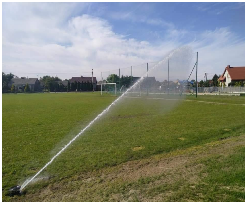
Nawodnienie boiska po wykonaniu prac
