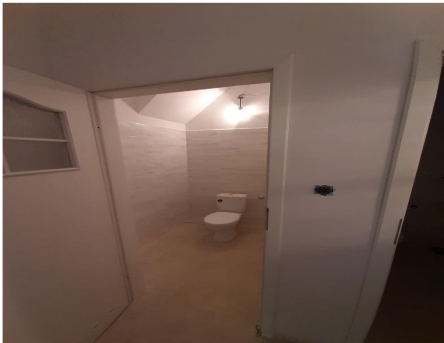
Łazienka po remoncie w świetlicy w Ciółkowie
