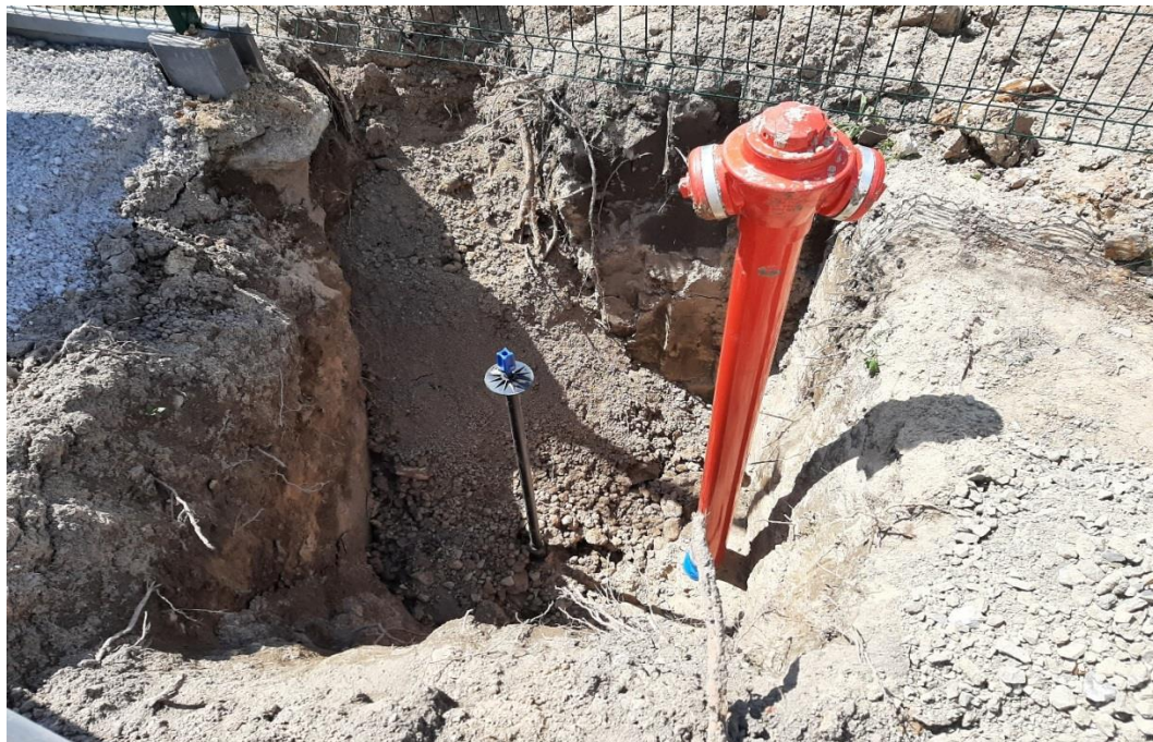
Wykop w trakcie budowy sieci wodociągowej
