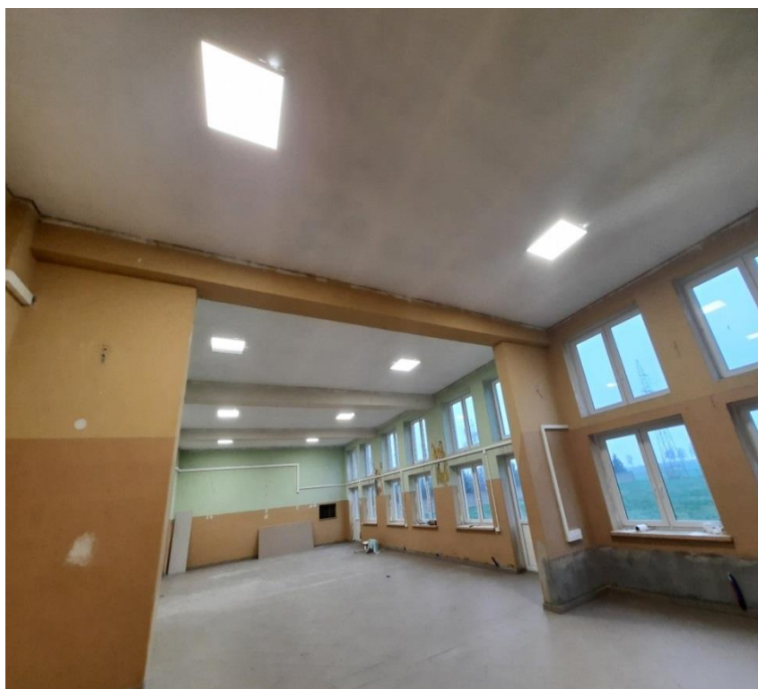
Sufit po remoncie w budynku strażnicy w Juryszewie
