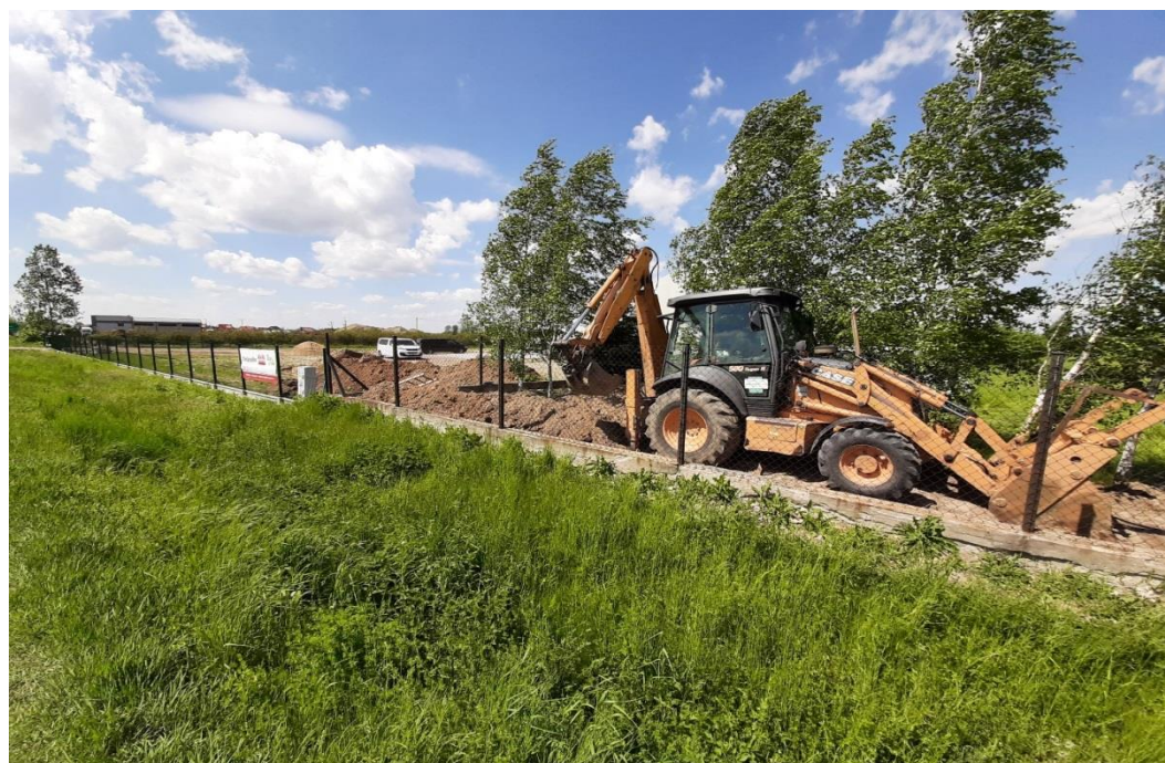
Budowa odcinka sieci wodociągowej wzdłuż drogi wojewódzkiej 567 w Rogozinie
