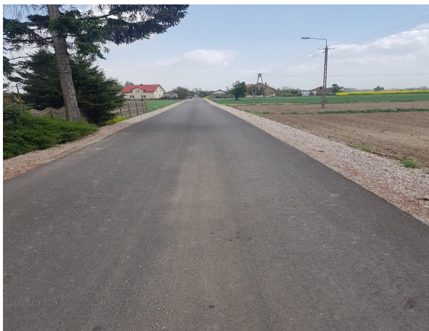
Droga po przebudowie Kosino „Pieńki”
