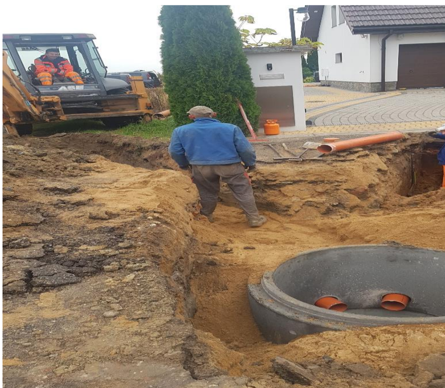
Budowa kanalizacji sanitarnej w miejscowości Stróżewko
