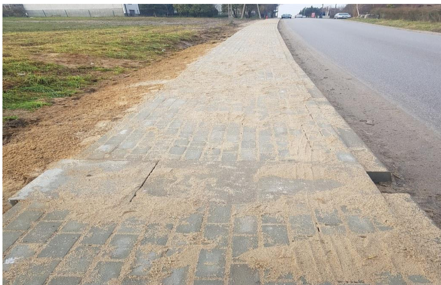
Chodnik po wybudowaniu z ciekim podchodnikowym
