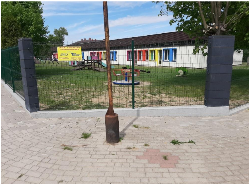
Nowo wybudowane ogrodzenie
