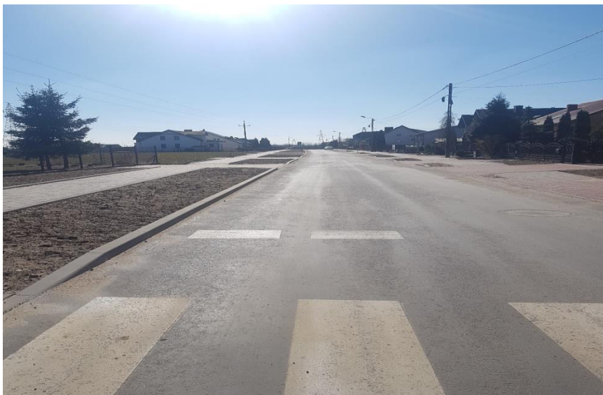
Ulica Wiśniowa w Radzanowie po przebudowie
