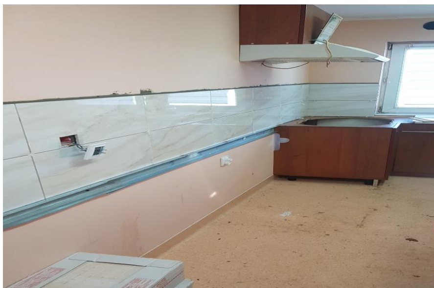
Remont pomieszczenia kuchni w świetlicy w Starym Boryszewie
