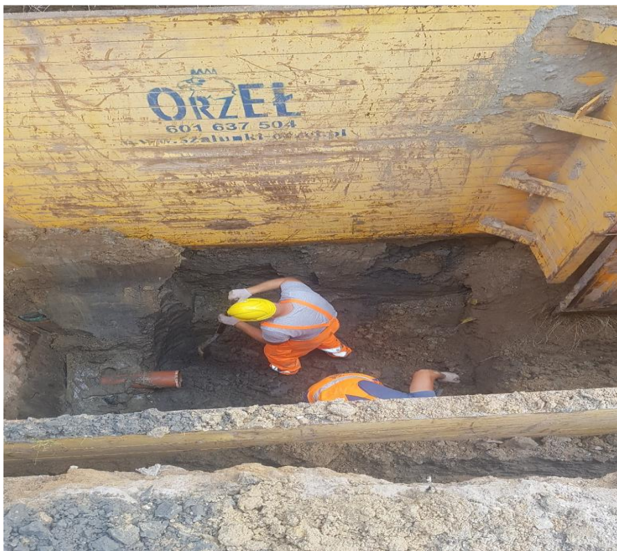
Wykop w trakcie wykonywania sieci kanalizacji sanitarnej w Rogozinie
