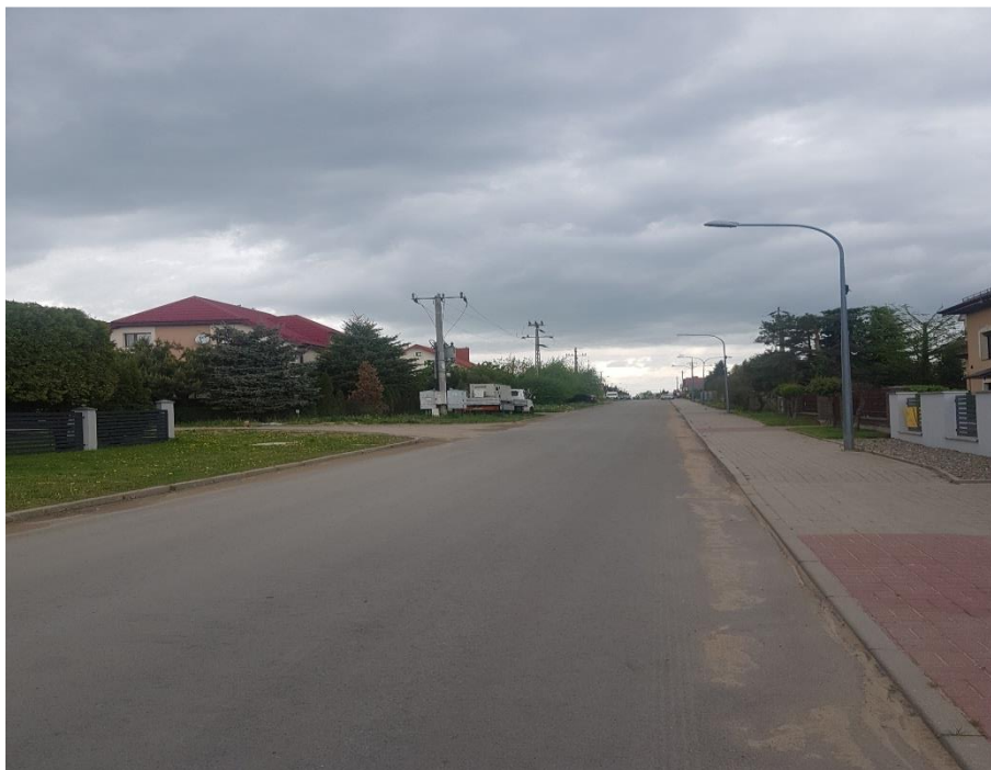
Ulica Słoneczna w Rogozinie po modernizacji
