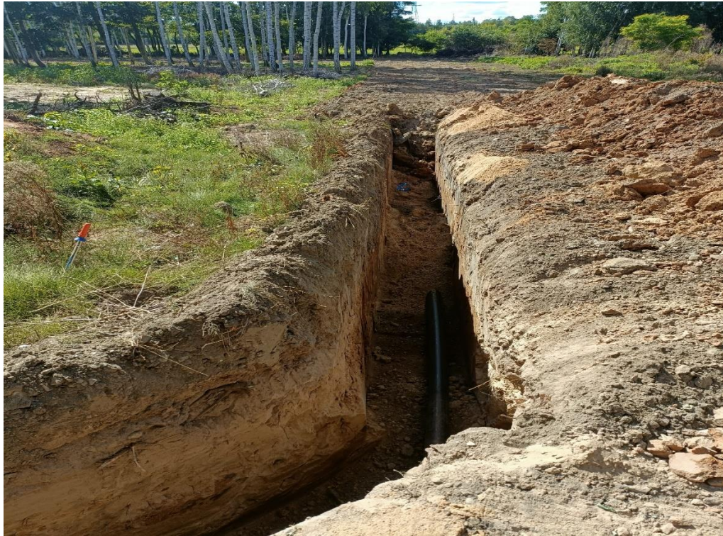
Wykop pod sieć wodociągową w Nowym Boryszewie
