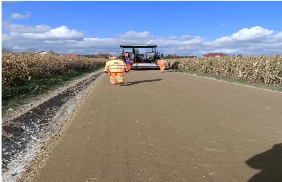
Zadanie w trakcie realizacji -podbudowa drogi gminnej w Kostrogaju
