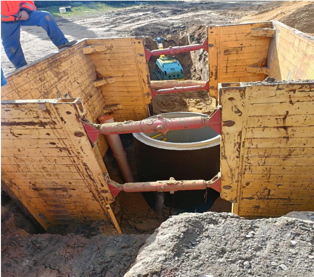
Budowa studni kanalizacyjnej w Rogozinie
