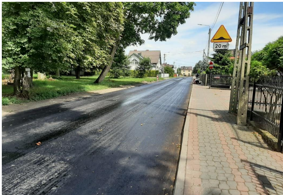
Zdjęcie w trakcie realizacji ul. Kredytowej w Radzanowie
