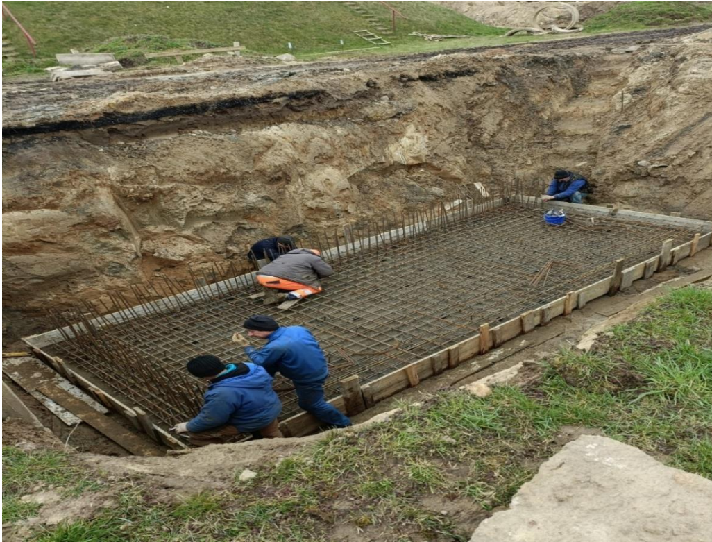
Prace zewnętrzne zbrojeniowe przy zbiorniku popłuczyn na Stacji Uzdatniania Wody
