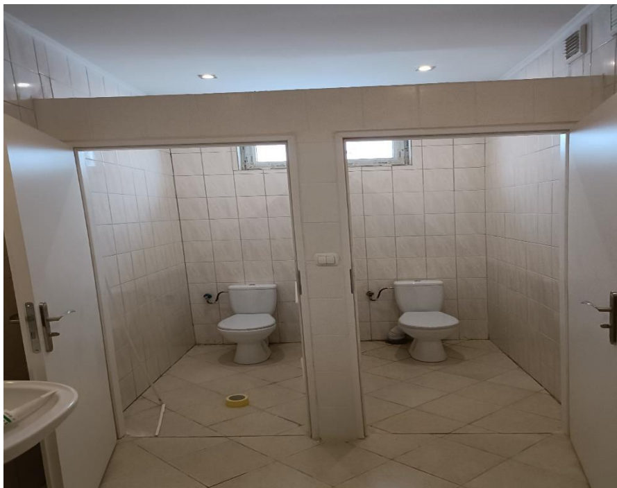
Wymiana armatury w łazienkach budynku OSP Woźniki
