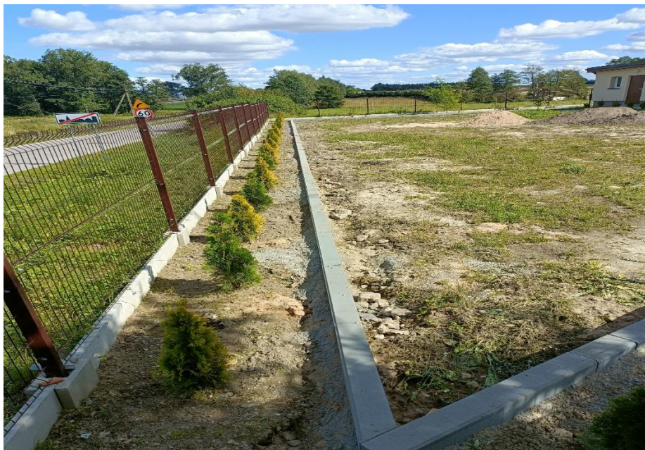
Ustawienie krawężników przy świetlicy w Białkowie
