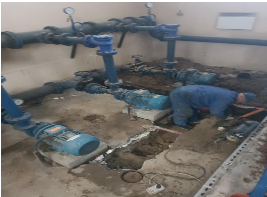
Prace wewnątrz budynku Stacji Uzdatniania Wody
