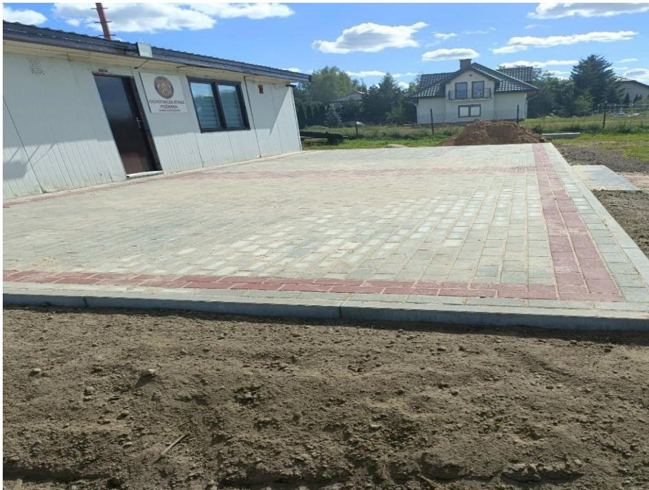
Utwardzenie placu przy świetlicy w Boryszewie Starym
