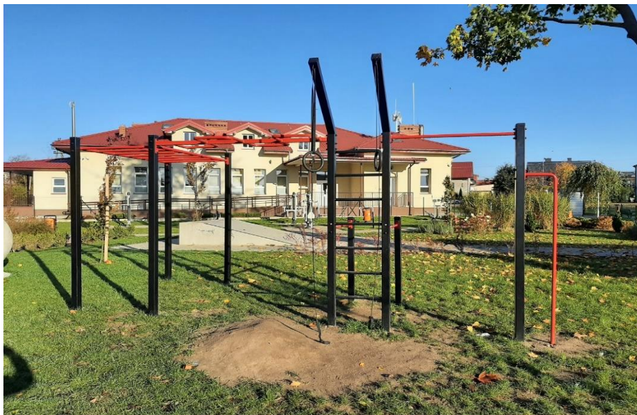
Nowo wybudowany obiekt na placu rekreacyjnym w Rogozinie
