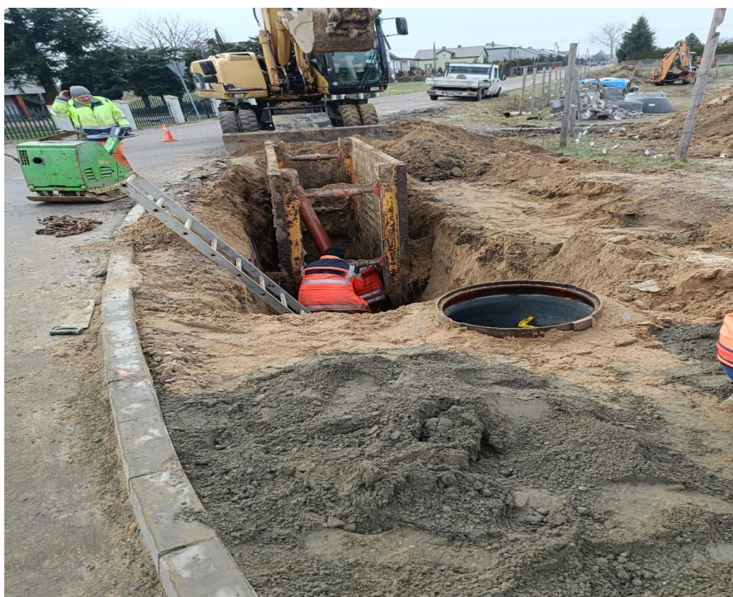
Budowa kanalizacji sanitarnej w Radzanowie ul. Płocka
