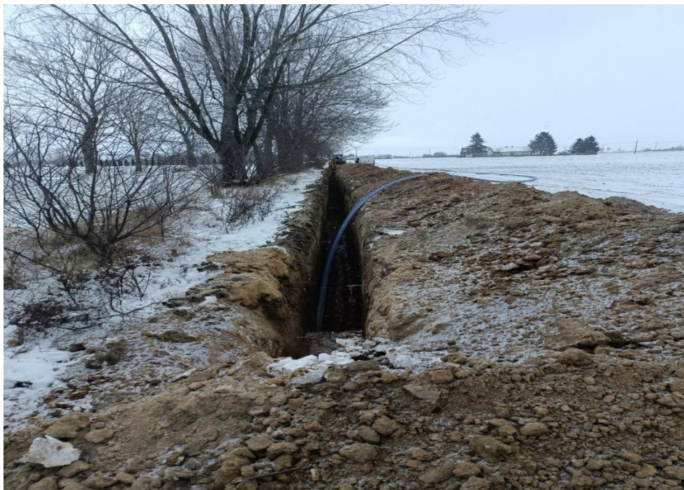
Wykop pod sieć wodociągową w Radzanowo-Dębniaki
