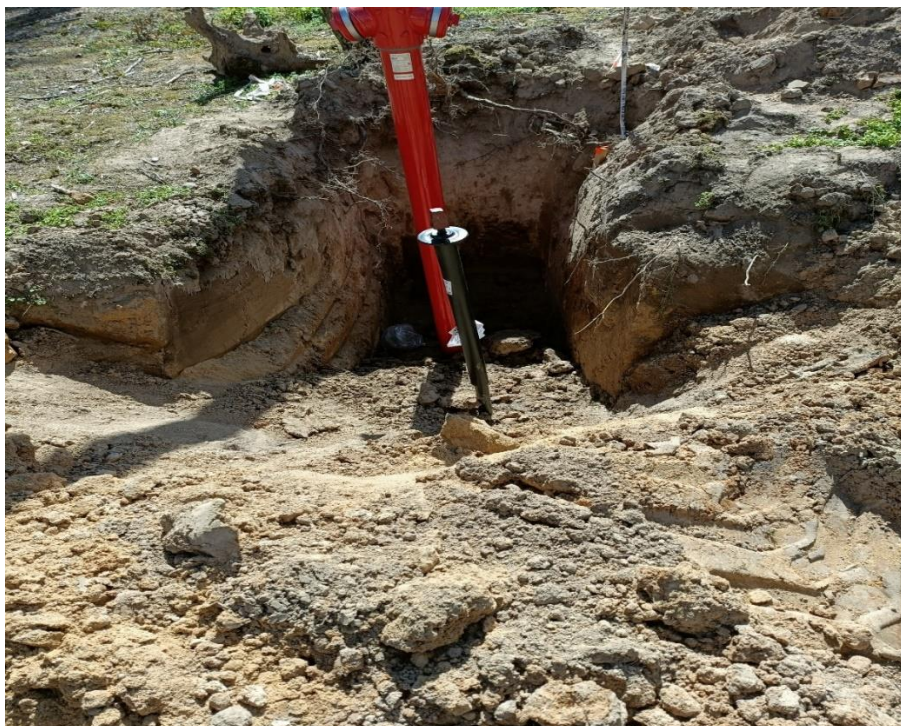
Posadowienie hydrantu na sieci wodociągowej w Stróżewku
