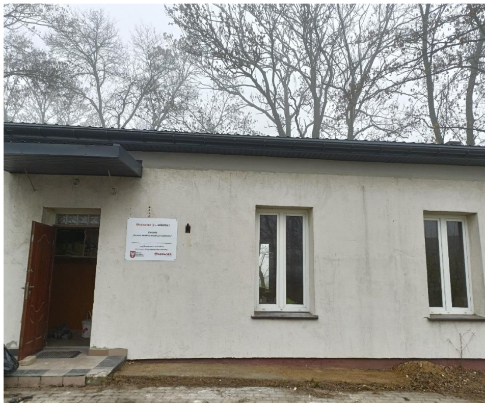
Budynek świetlicy po remoncie dachu
