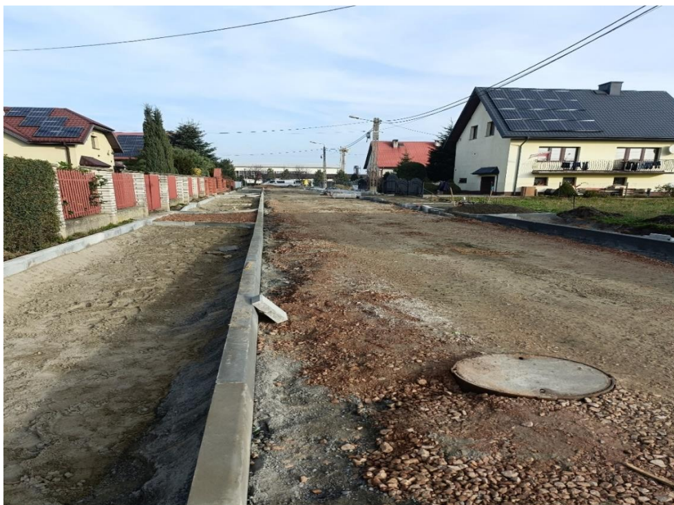
Ulica Klonowa w Radzanowie w trakcie realizacji
