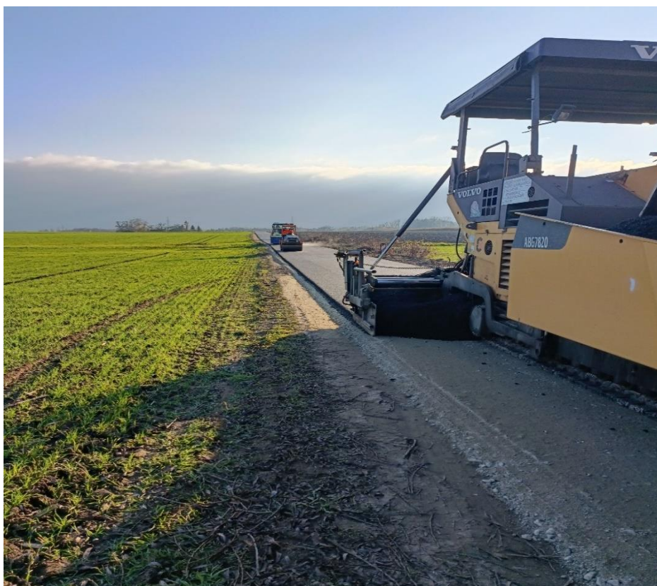
Zdjęcie w trakcie realizacji przebudowy drogi gminnej w Wodzyminie
