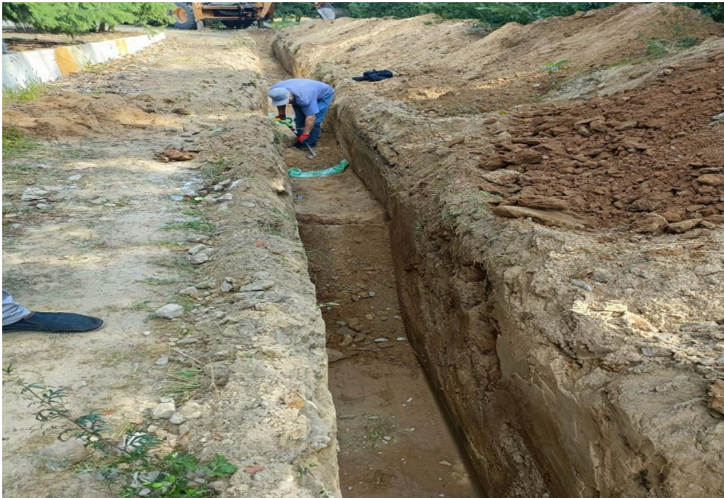
Prace odkrywkowe ( wykonywane przez służby archeologiczne) przy budowie sieci wodociągowej w Nowym Boryszewie
