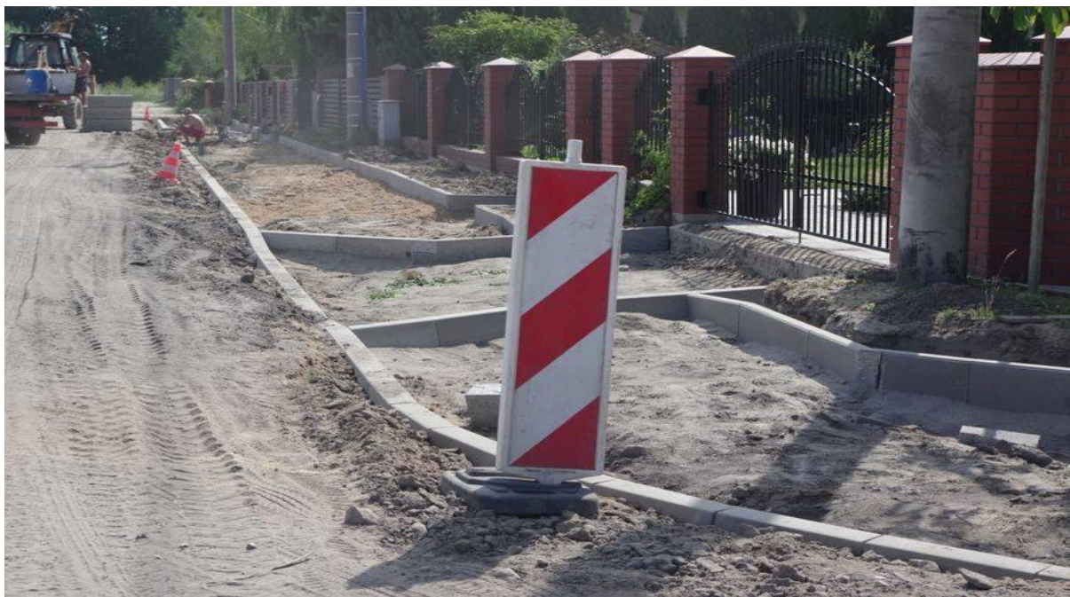
ul. Osiedlowa w Rogozinie w trakcie realizacji zadania
