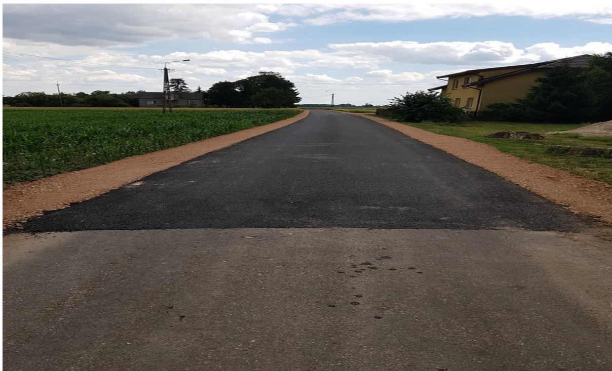
Odcinek drogi gminnej w miejscowości Dźwierzno po zakończeniu zadania
