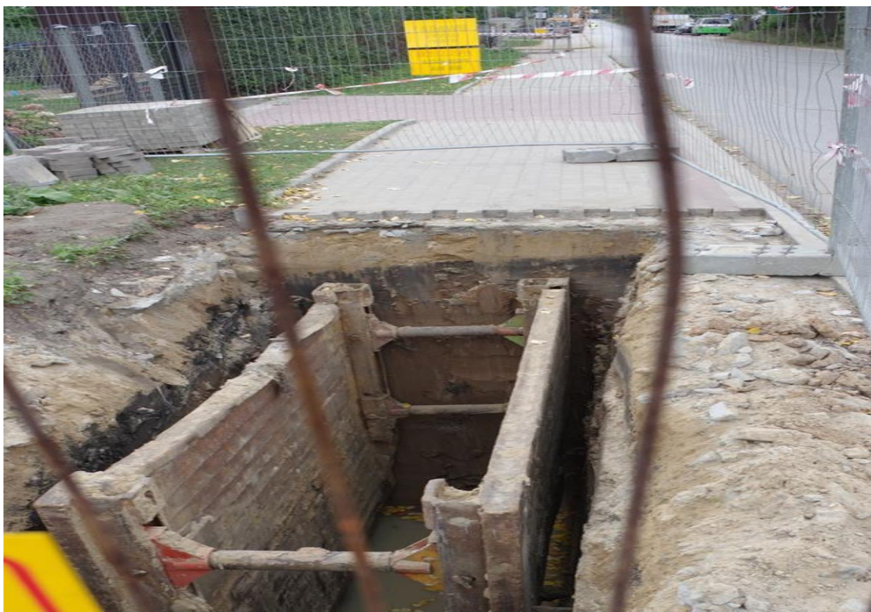
Budowa kanalizacji sanitarnej w Rogozinie, ul. Mazowiecka
