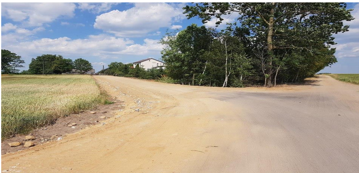
Droga w miejscowości Juryszewo po zakończeniu inwestycji
