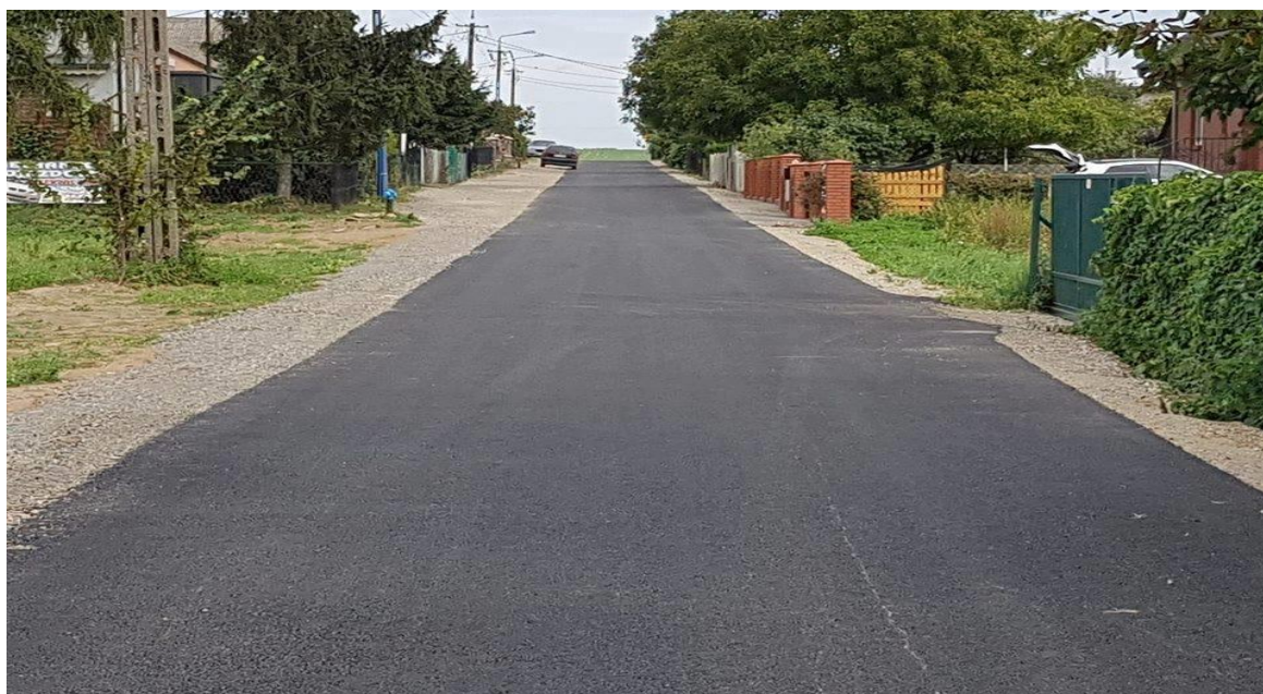
Odcinek drogi gminnej w miejscowości Ciólkowo po modernizacji
