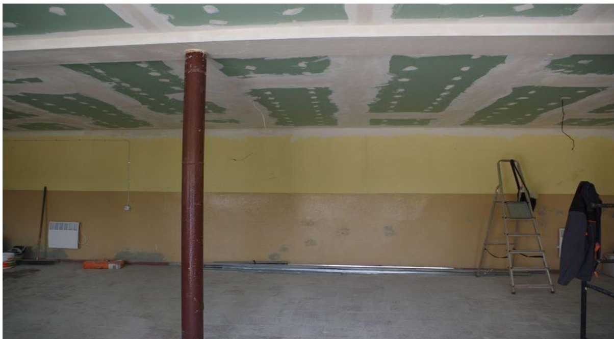
Świetlica wiejska w miejscowości Białkowo w trakcie realizacji zadania
