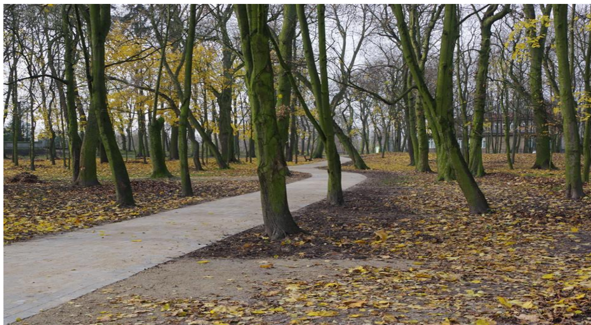
Park zabytkowy w Radzanowie po zakończeniu budowy ciągu pieszo-jezdnego
