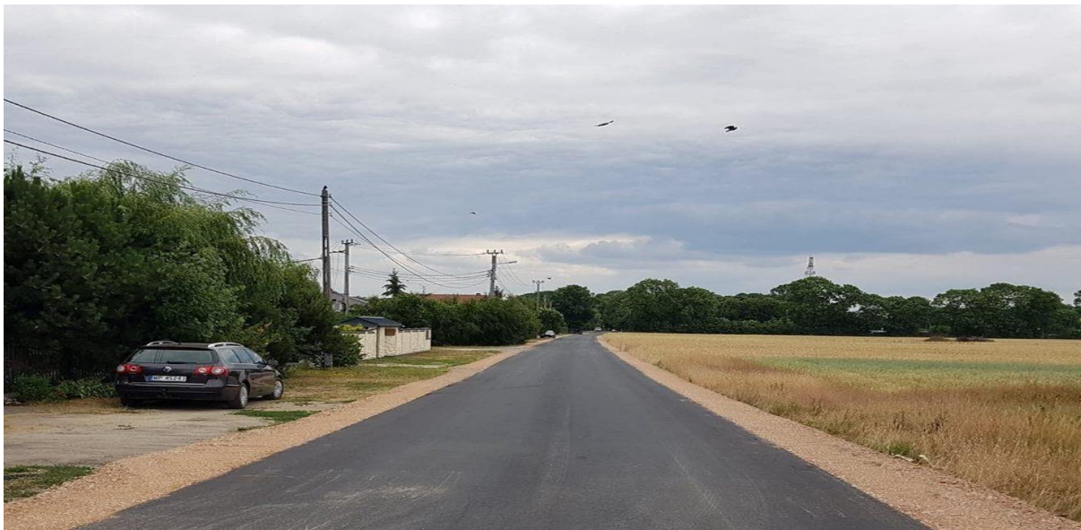
Ulica Rolna w Radzanowie po zakończeniu inwestycji
