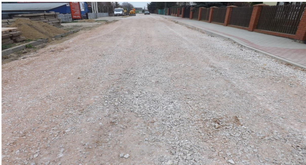
Droga gminna w miejscowości Stróżewko w trakcie realizacji inwestycji
