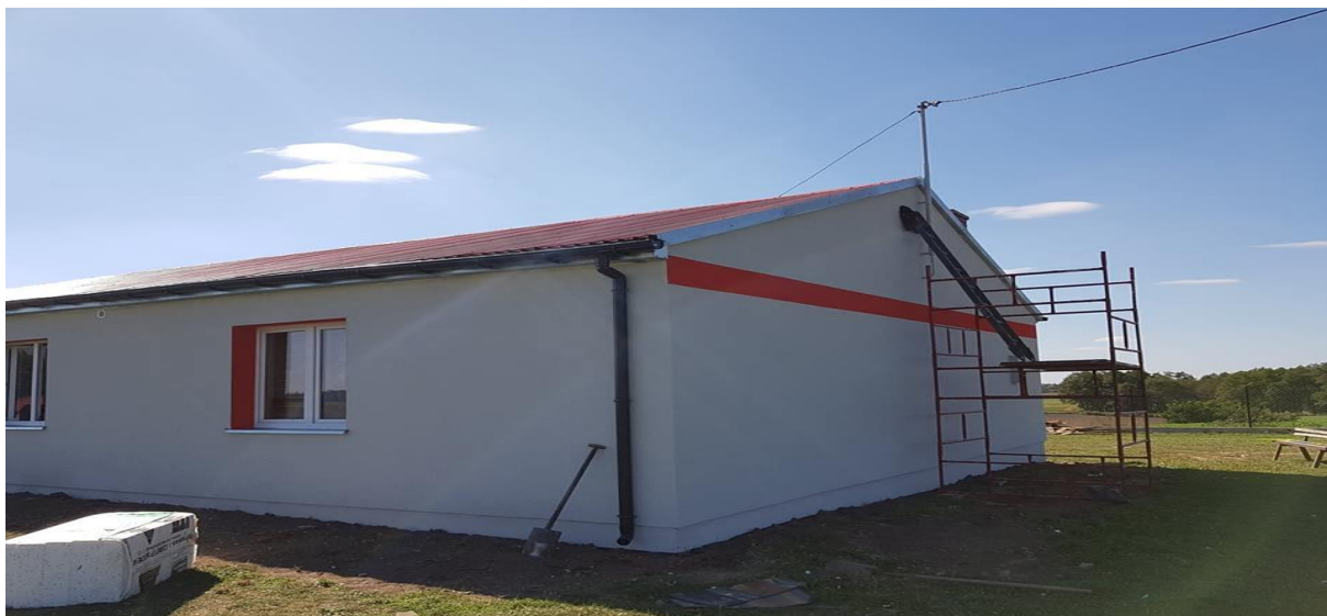
Remiza OSP Szczytno w trakcie realizacji zadania
