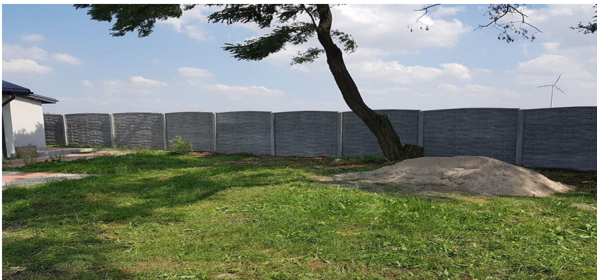
Ogrodzenie części placu przy świetlicy wiejskiej w Męczeninie
