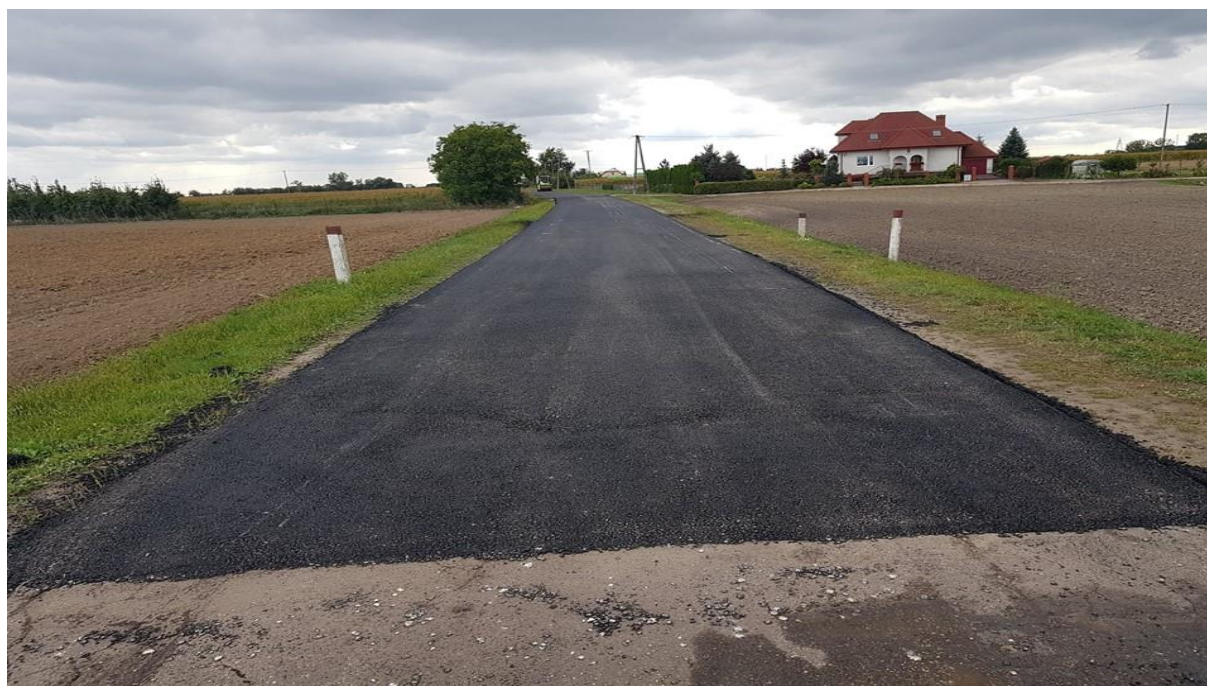
Droga w miejscowości Kostrogaj po zakończeniu inwestycji
