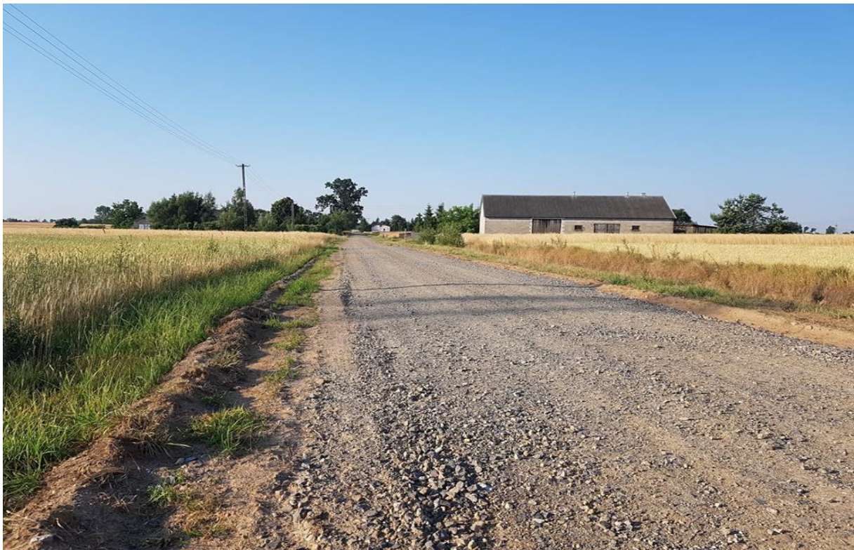
Zmodernizowana droga w miejscowości Wólka
