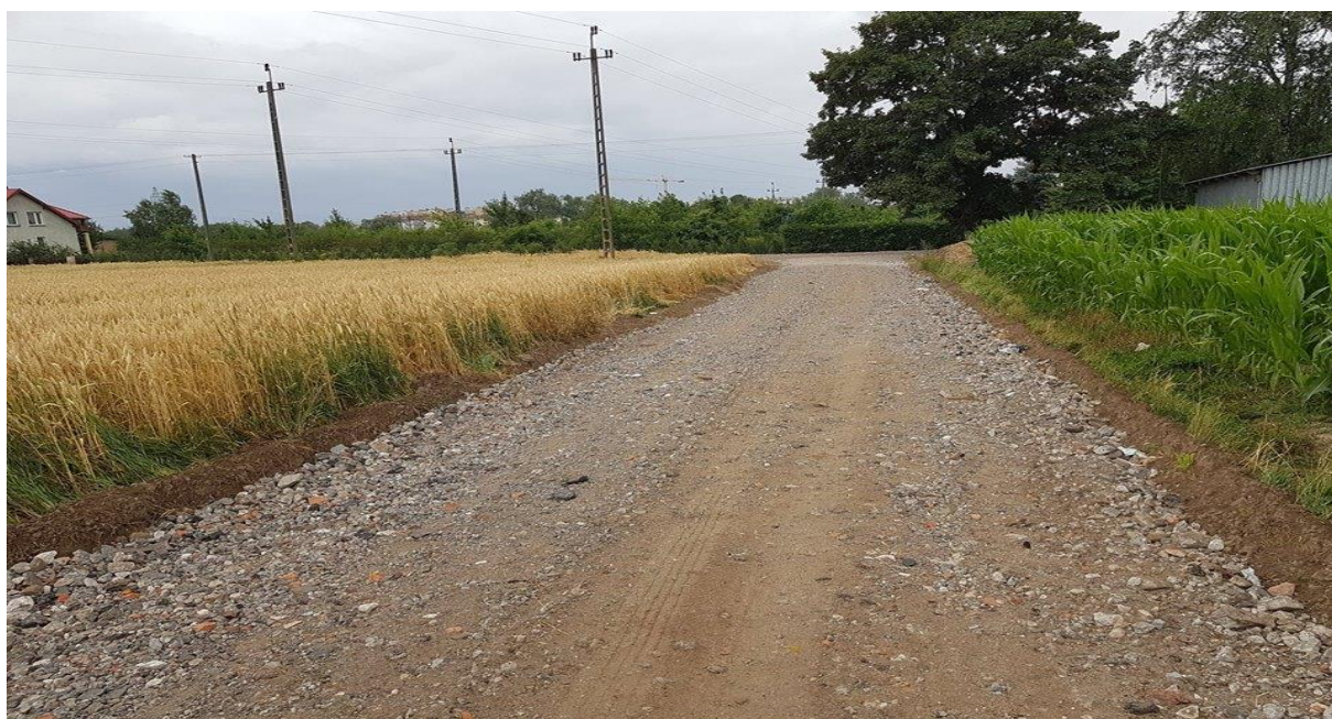
Droga gminna w Nowym Boryszewie po zakończeniu inwestycji
