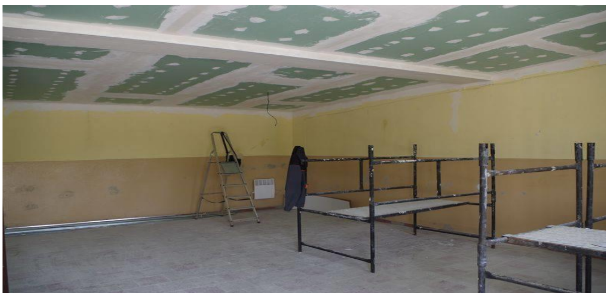
Świetlica wiejska w miejscowości Białkowo w trakcie realizacji zadania
