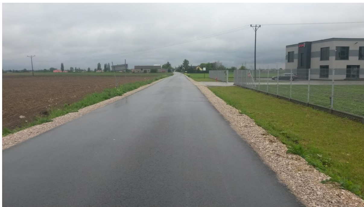
Droga gminna w miejscowości Stróżewko po zakończeniu inwestycji
