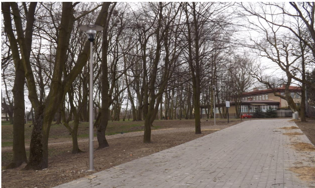
Zabytkowy park w Radzanowie po zakończeniu montażu lamp oświetleniowych
