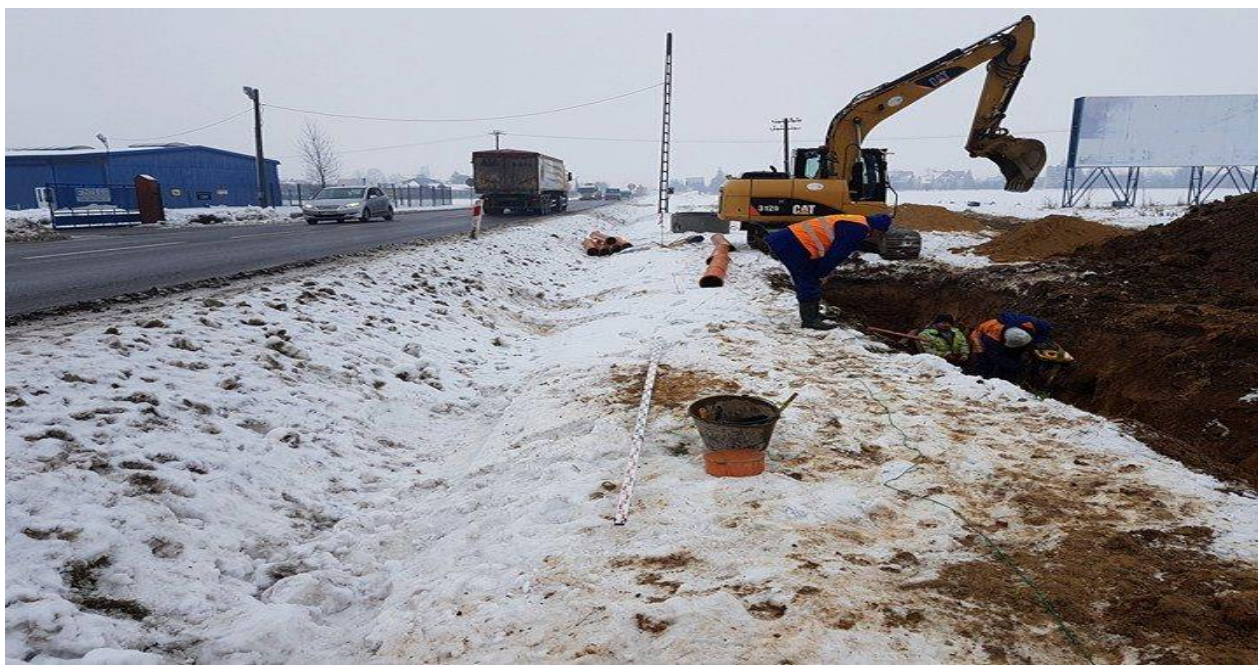
Budowa kanalizacji sanitarnej w Nowym Boryszewie
