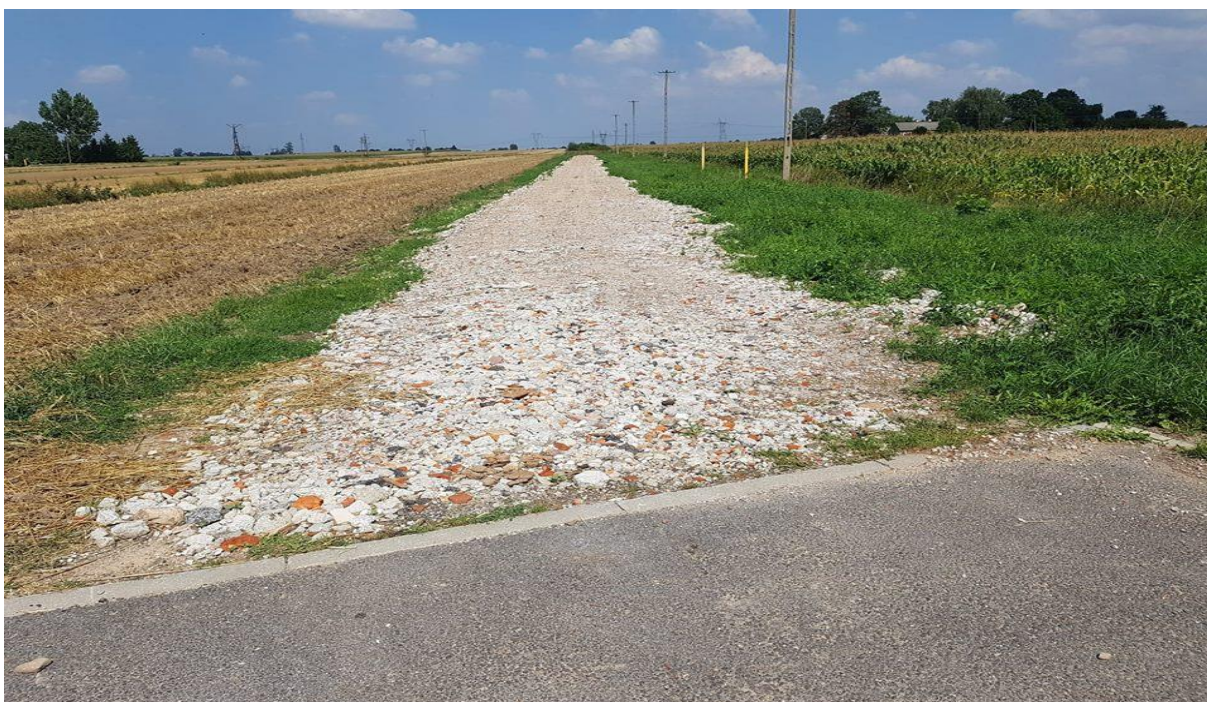
Utwardzona droga gminna w Męczeninie
