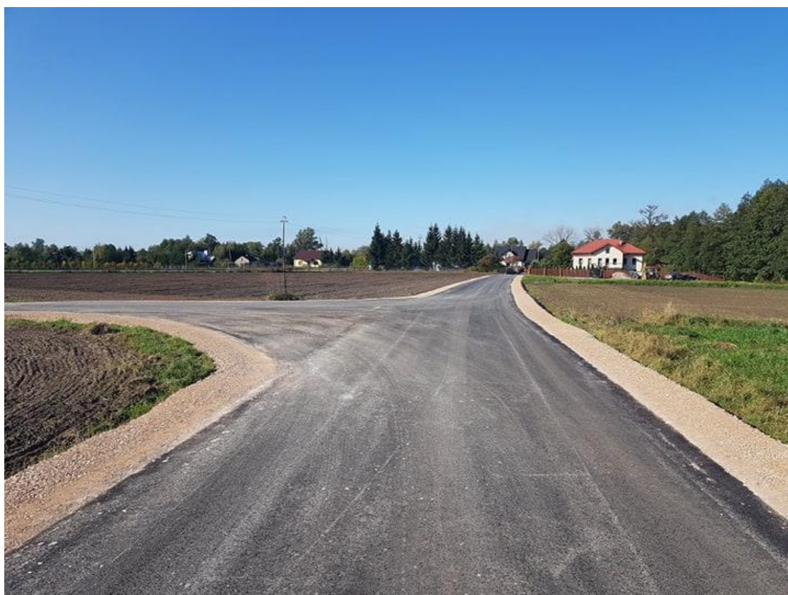
Przebudowana droga w miejscowości Stare Boryszewo.
