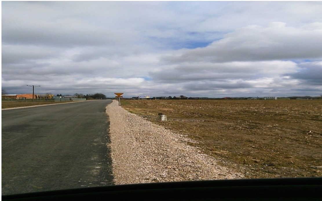
Droga gminna w miejscowości Stróżewko po zakończeniu prac.
