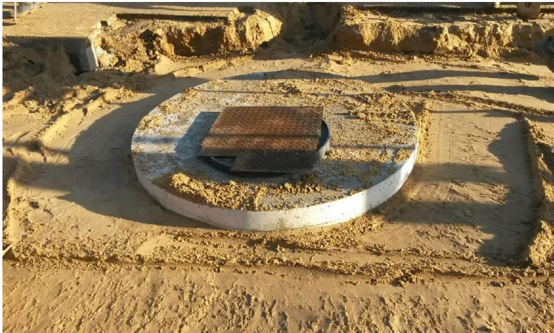
Fragment sieci kanalizacyjnej- studnia kanalizacyjna w trakcie budowy.
