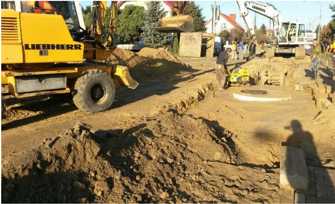
Budowa sieci kanalizacyjnej w Rogozinie.
