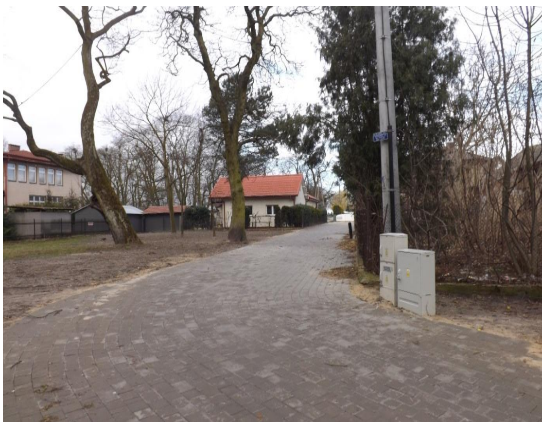
Ciąg pieszo –jezdny w Radzanowie w ulicy Parkowej po zakończeniu prac.
