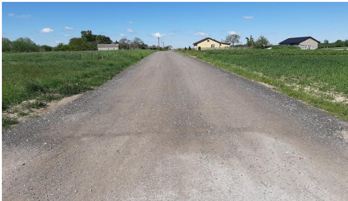
Droga gminna w Chomętowie po wbudowaniu destruktu asfaltowego.
