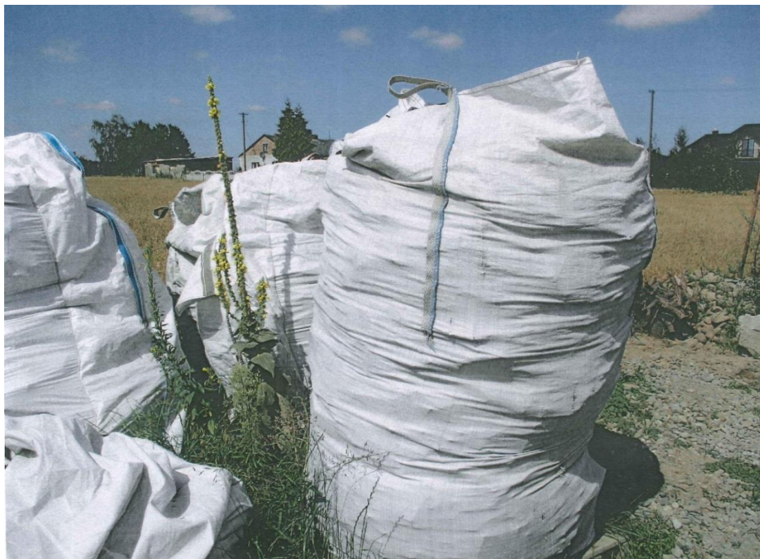
Azbest rozdrobniony przygotowany do odbioru.
