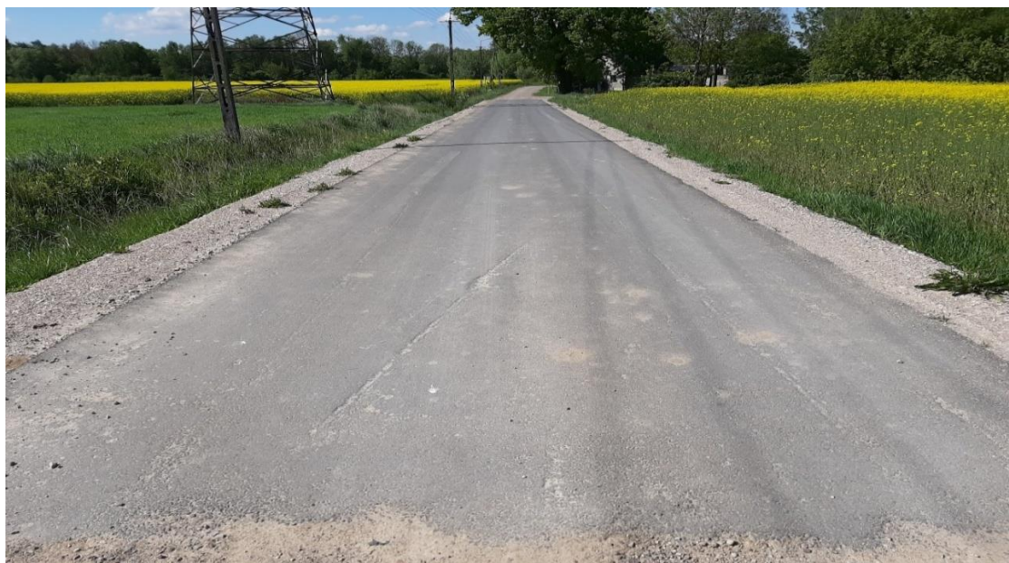
Droga gminna w Wodzyminie po modernizacji.
