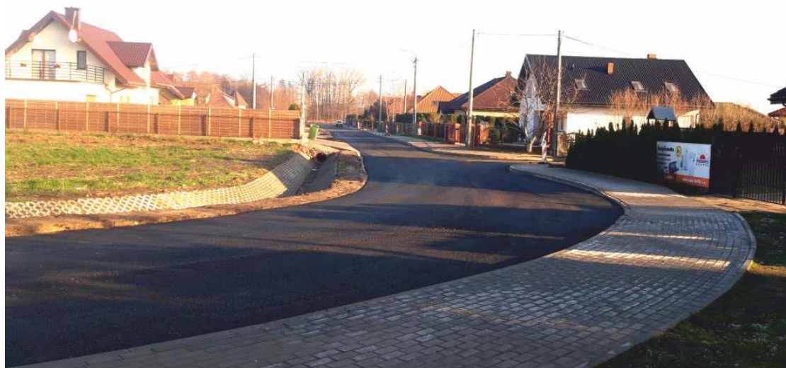
Ulica Osiedlowa w Rogozinie po zakończeniu prac.
