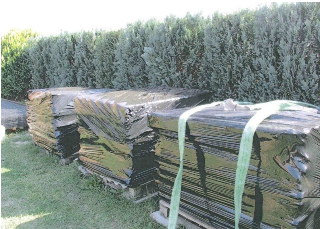
Płyty azbestowe na paletach przygotowane do odbioru.
