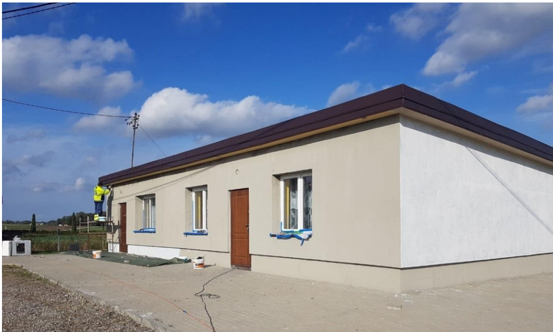
Budynek świetlicy wiejskiej w Białkowie w trakcie wykonania prac.
