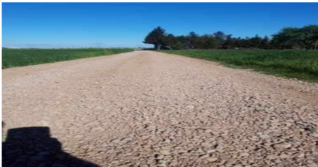
Droga gminna w Dźwierznie po wbudowaniu tłucznia.
