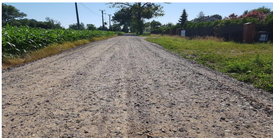
Droga w Brochocinie po wbudowaniu kruszywa.
