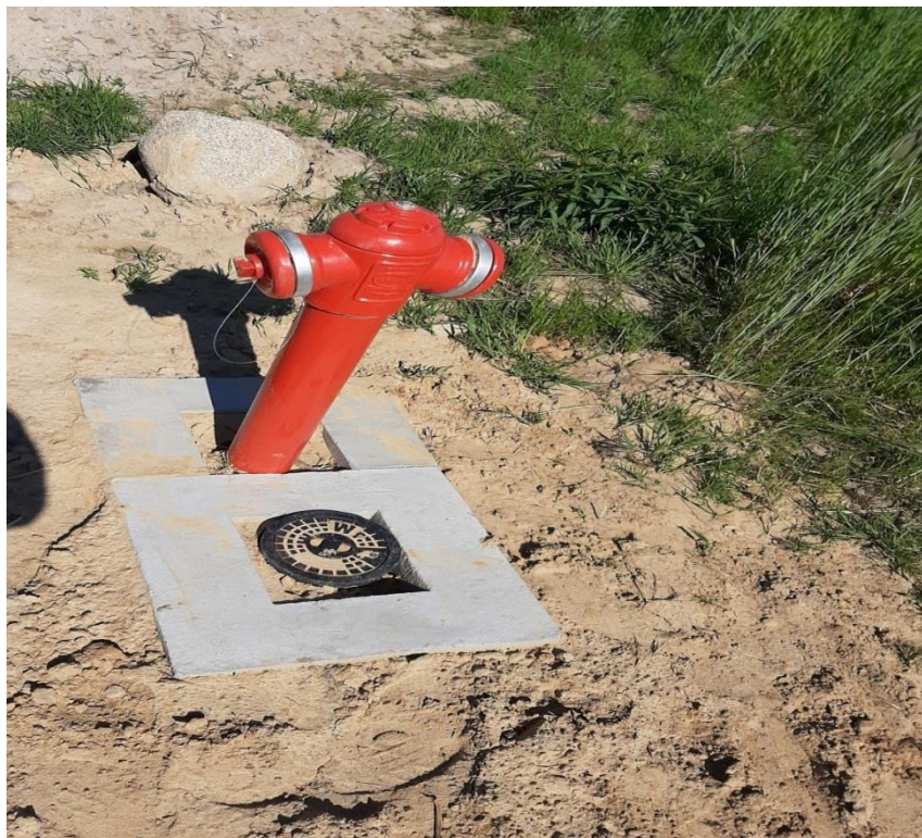
Elementy sieci wodociągowej w Radzanowie po zakończeniu prac.
