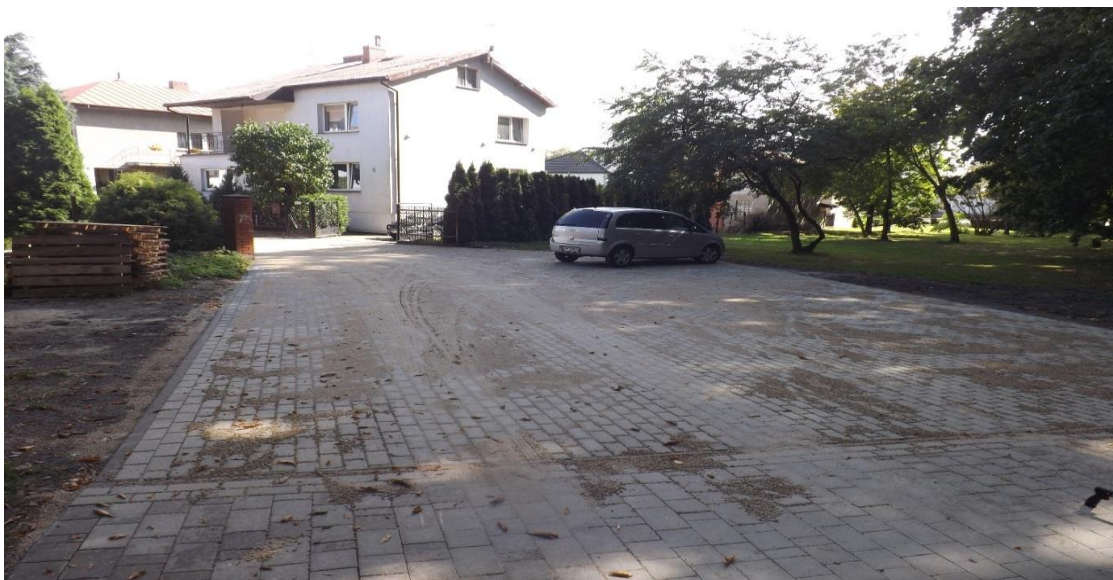
Ciąg pieszo –jezdny w Radzanowie w ulicy Parkowej po zakończeniu prac.
