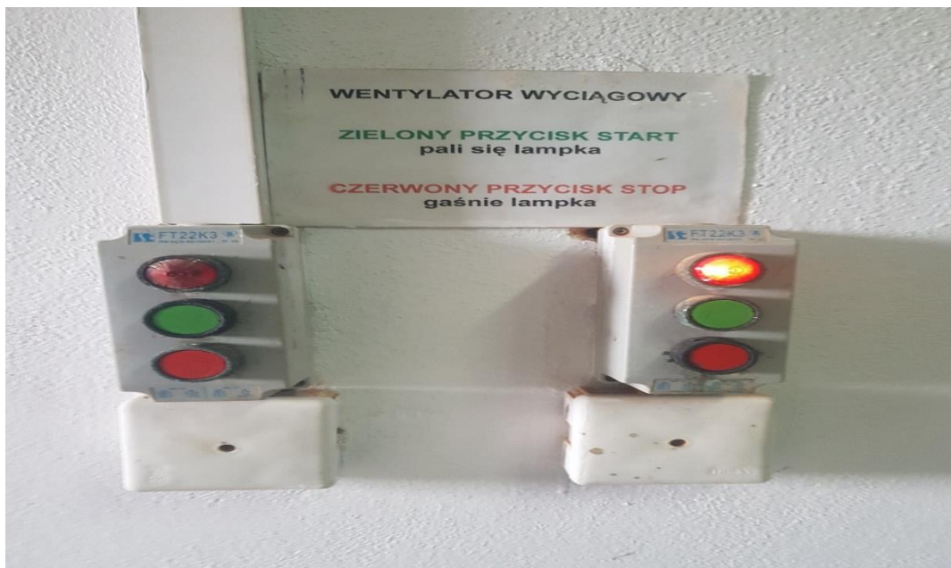
Sterowania wentylatora wyciągowego
