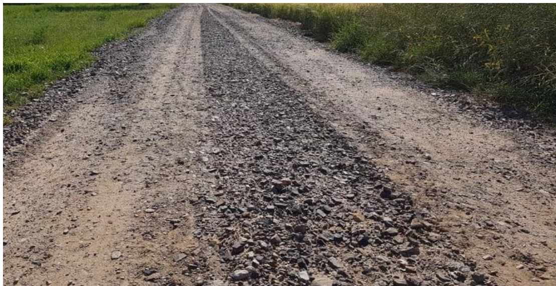
Droga gminna w Kostrogaju po wbudowaniu tłucznia.
