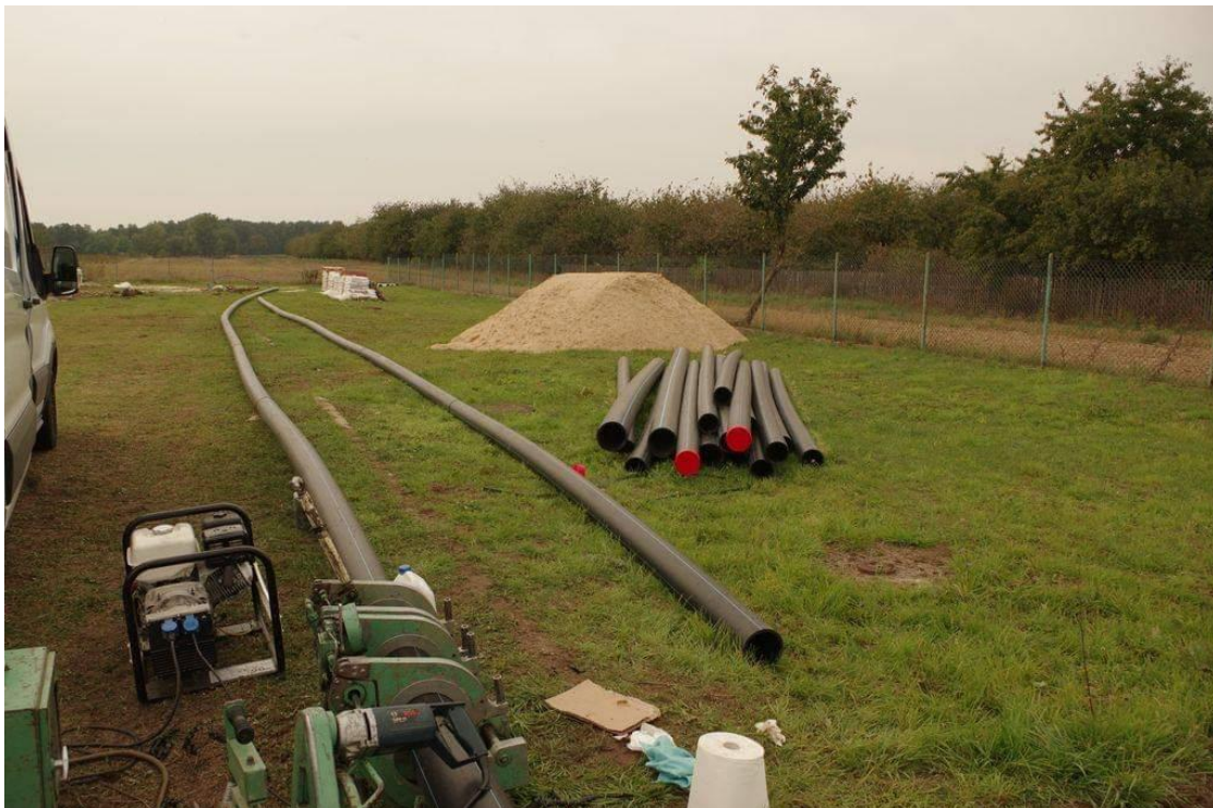
Teren przy Stacji Uzdatniania Wody w trakcie prac.
