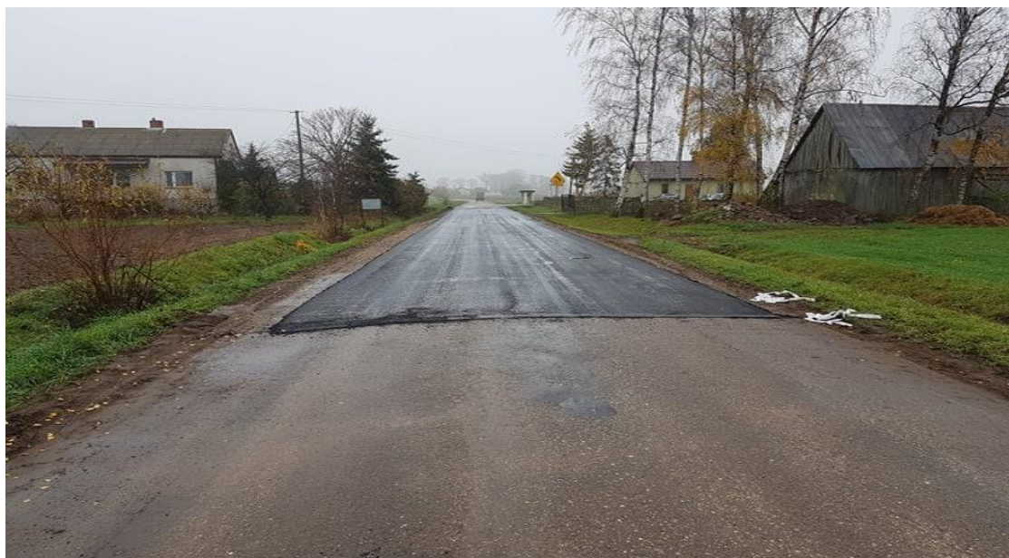
Droga gminna w Kosinie po modernizacji.
