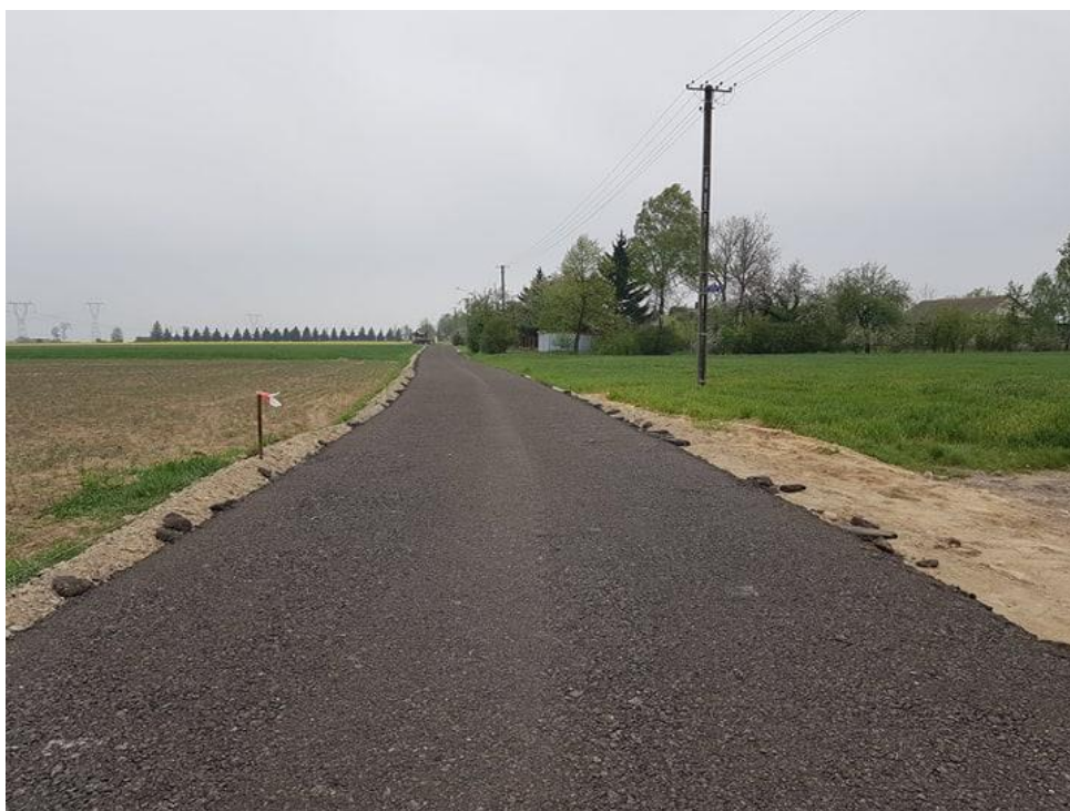
Droga w miejscowości Ciółkówko po modernizacji.
