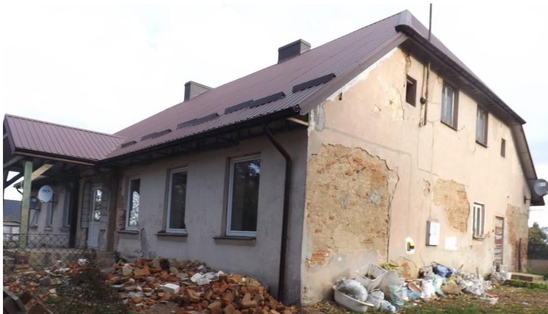
Budynek po wymianie pokrycia dachowego.
