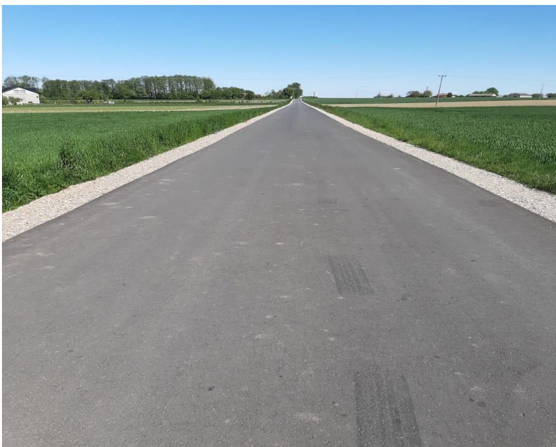
Przebudowana droga w miejscowości Juryszewo.
