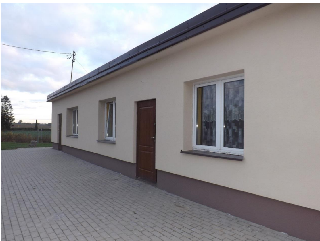
Budynek świetlicy wiejskiej w Białkowie po wykonaniu prac.
