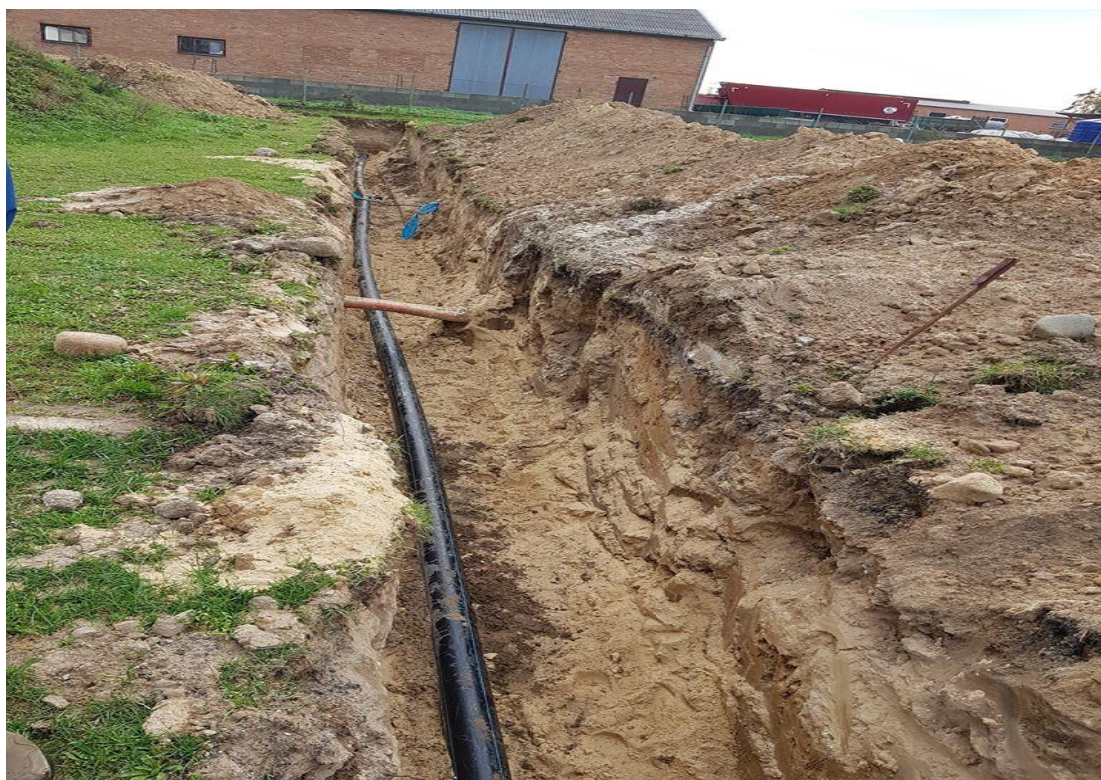
Stacja Uzdatniania Wody w trakcie wykonywania prac.
